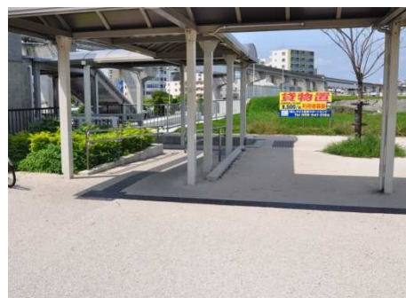
バリアフリーに対応した歩道空間
