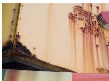
サビで汚ダレが出ている状態
