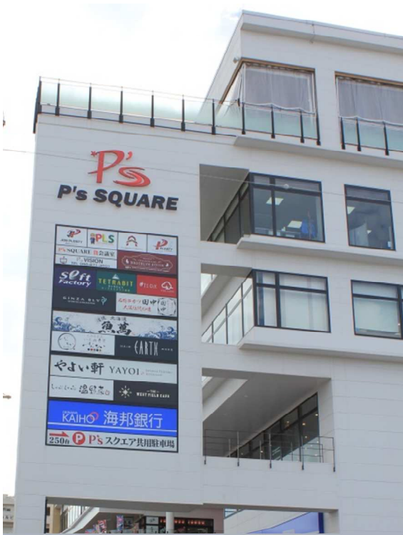
建物の設計段階で広告物スペースがあらかじめ計画されている
