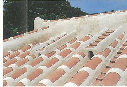
屋根の換気口
