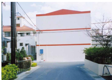
平面を色だけで塗り分けると不自然になりがち。この建物はその後塗り替えられた
