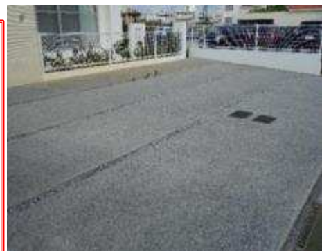
コンクリート舗装に浸透性の目地を設けた事例
