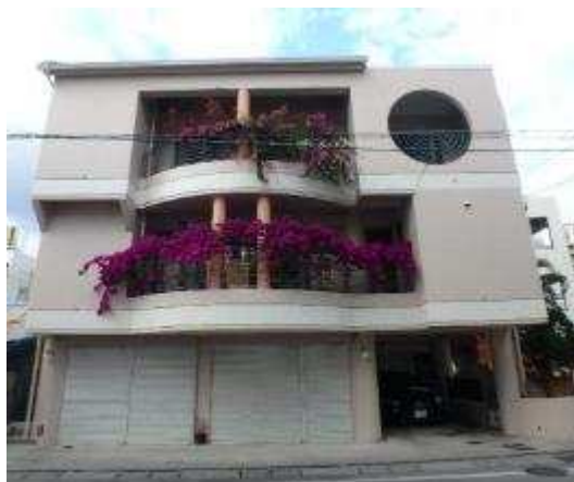
鋼製の手すりにブーゲンビリアを登はんさせ、壁面緑化を行い良好な景観を形成
