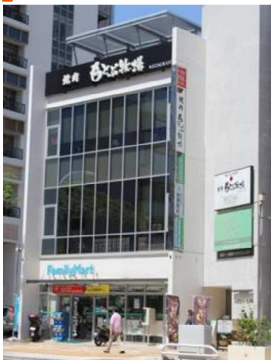
袖壁の一部をサインとした事例
