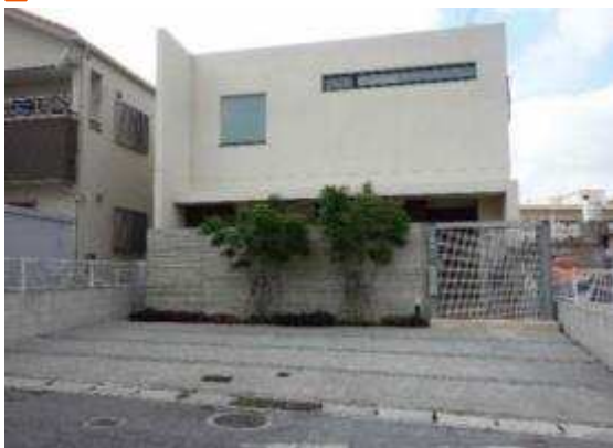
駐車スペースは、洗い出しや化粧目地でデザインし、わずかなスペースを活用して緑化修景した事例
