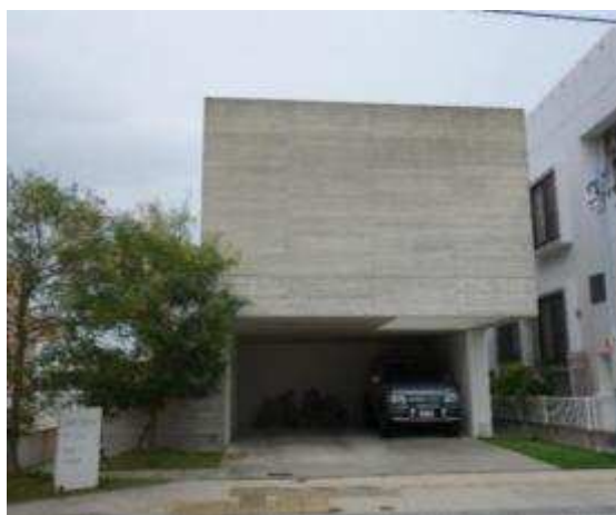
打ち出しコンクリートの素地色を生かし、杉板型枠を用いることで、外観に豊かな表情を演出
