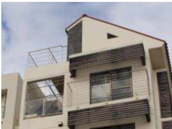
ルーバーで室外機を隠した事例
