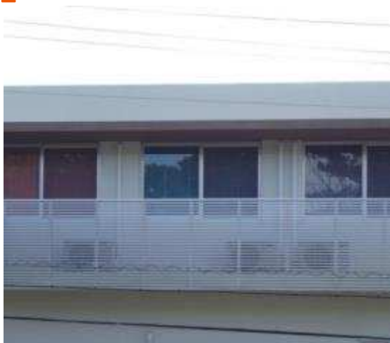
銅製の横型ルーバーで室外機を隠した事例
