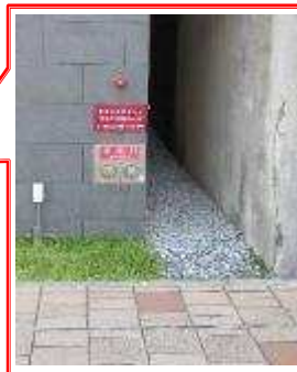
敷地境界部分に透水性のある砂利敷を行った事例
