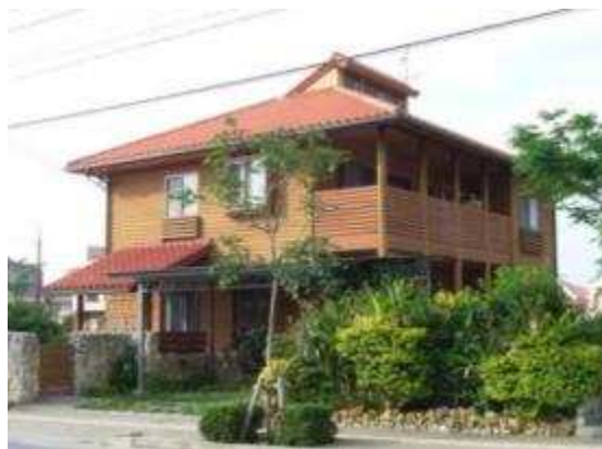
S型瓦を葺いた屋根
