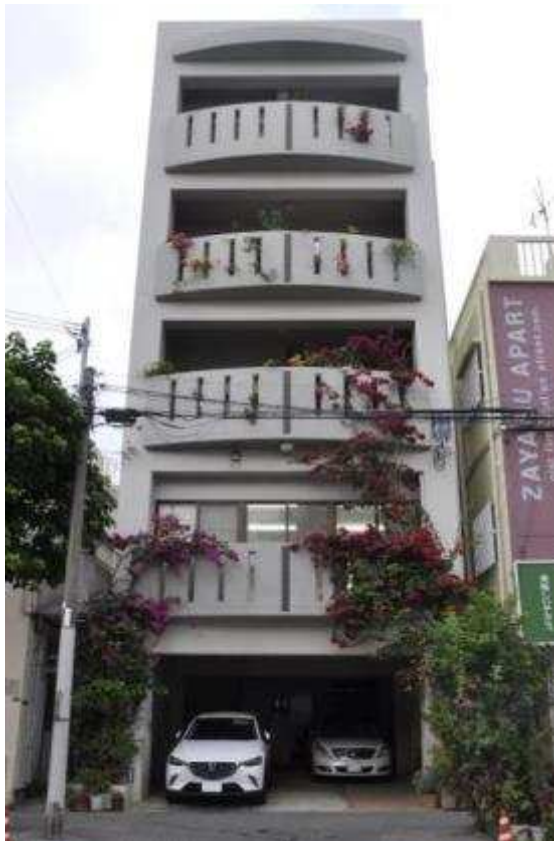
コンクリート手すり壁のスリット部分から覗くブーゲンビレアが、通りの潤いを創出
