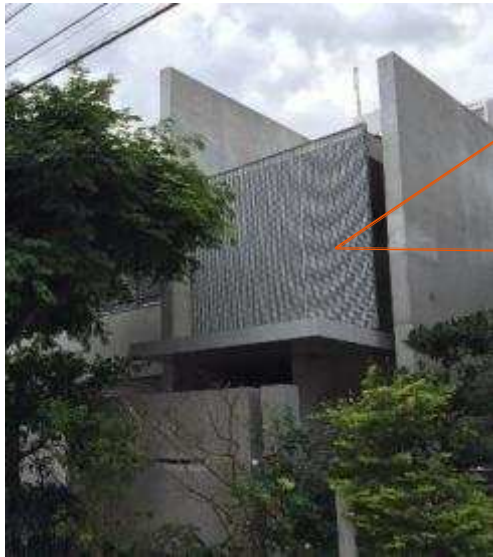
FRPグレーチングを活用し修景した事例（外部）
