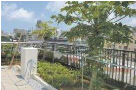
屋上の一部を緑化した事例
