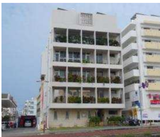
銅製手すりの部分から覗く植栽が通りの潤いを創出
