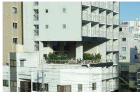
建物の中層部を活用した緑化の事例
