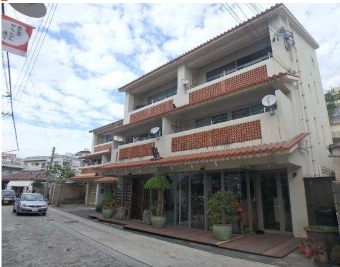
赤瓦を用いた屋根により伝統的な街並みに配慮
