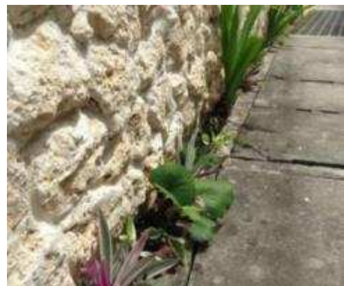
わずかなスペースを活用した緑化(道路境界)
