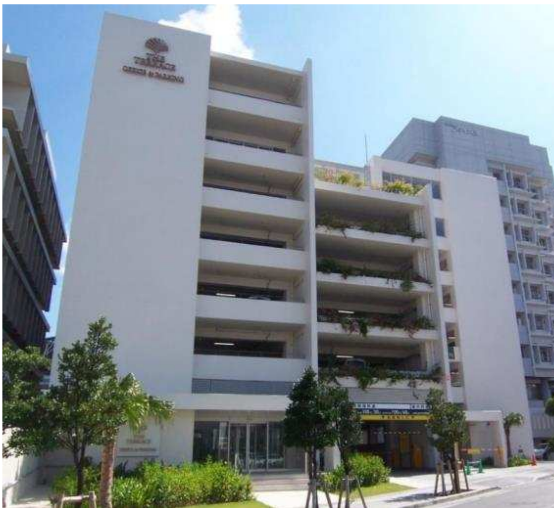
壁面側にプランタスペースを設けることで、駐車場壁面に表情の変化を与える
