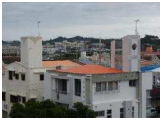
コンクリートで隠した事例
