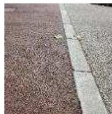
透水性アスファルト
