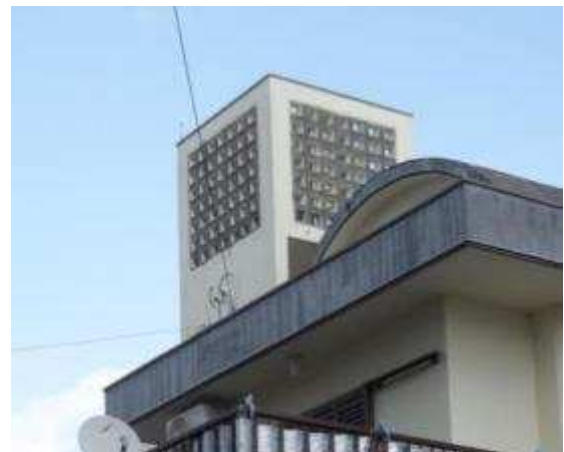
花ブロックを用いて修景した事例
