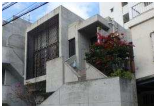
建物の一部に緑化を施すことで建築物に潤いを創出
