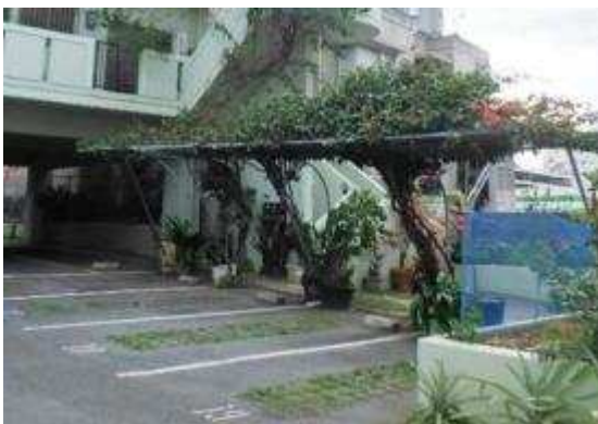
駐車場の屋根部にツル性植物を這わせ、緑陰を創出
