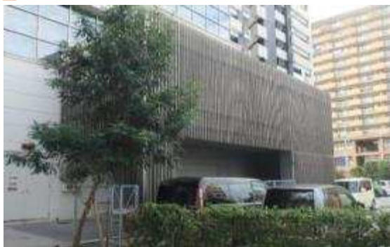
ルーバーで室外機を隠した事例
