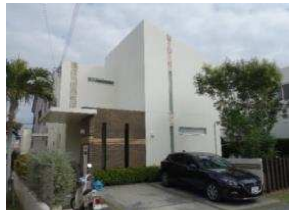
建築物の1階部分(低層部)に補助色を用いることで外観に変化を与えている
