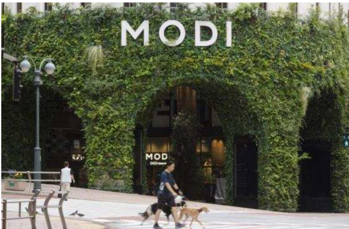
プランターユニットによる壁面緑化と広告を融合させ、緑豊かな玄関アプローチへと改修
