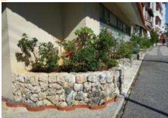
琉球石灰岩による石垣
