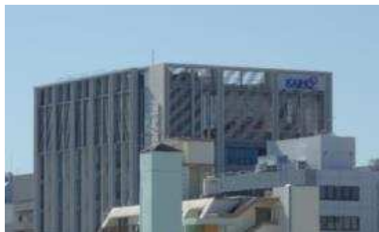
建物とルーバーを一体的な計画とし、意匠を崩さずに設備機器を隠した事例
