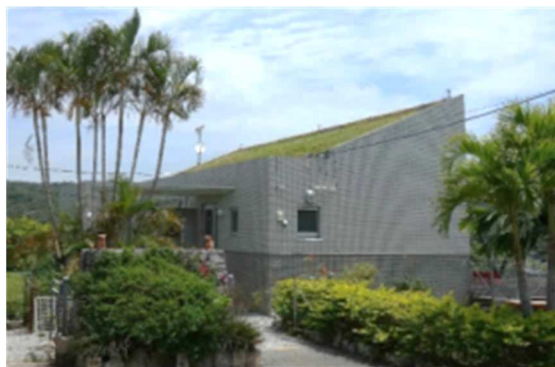
勾配屋根に合わせて屋上緑化を行うことで、遠方からの景観にも配慮
