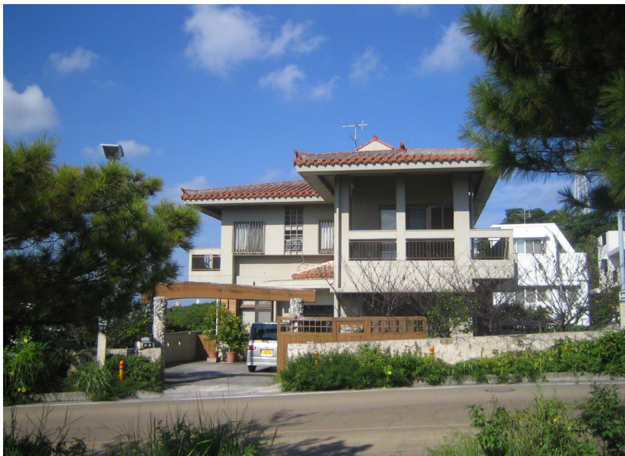
寒川線沿いの住宅
