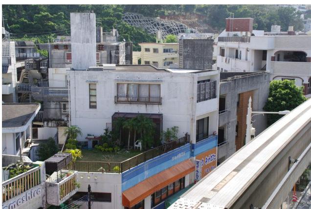
屋上緑化をしている住宅（儀保駅付近）
