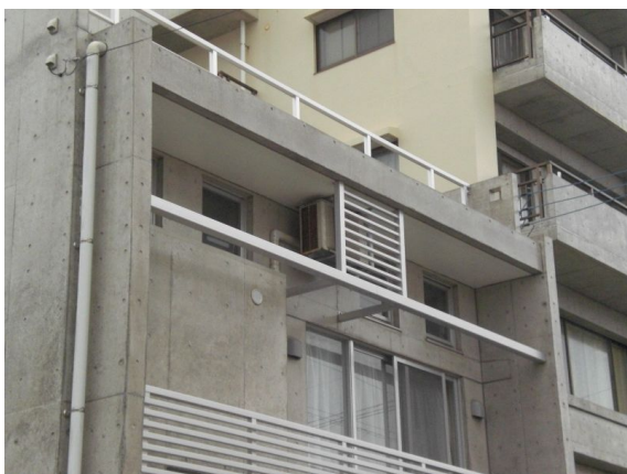
室外機を目隠ししている事例
