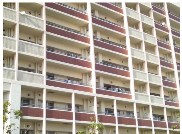
物干しを手すり型とし、周囲から見えにくい位置に設置している事例
