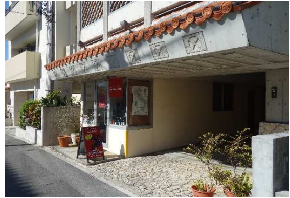
石素材を用いた車庫
