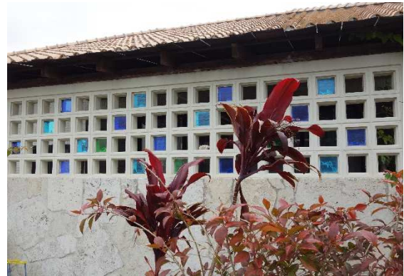
花ブロックに琉球ガラスをはめ込んだ事例
