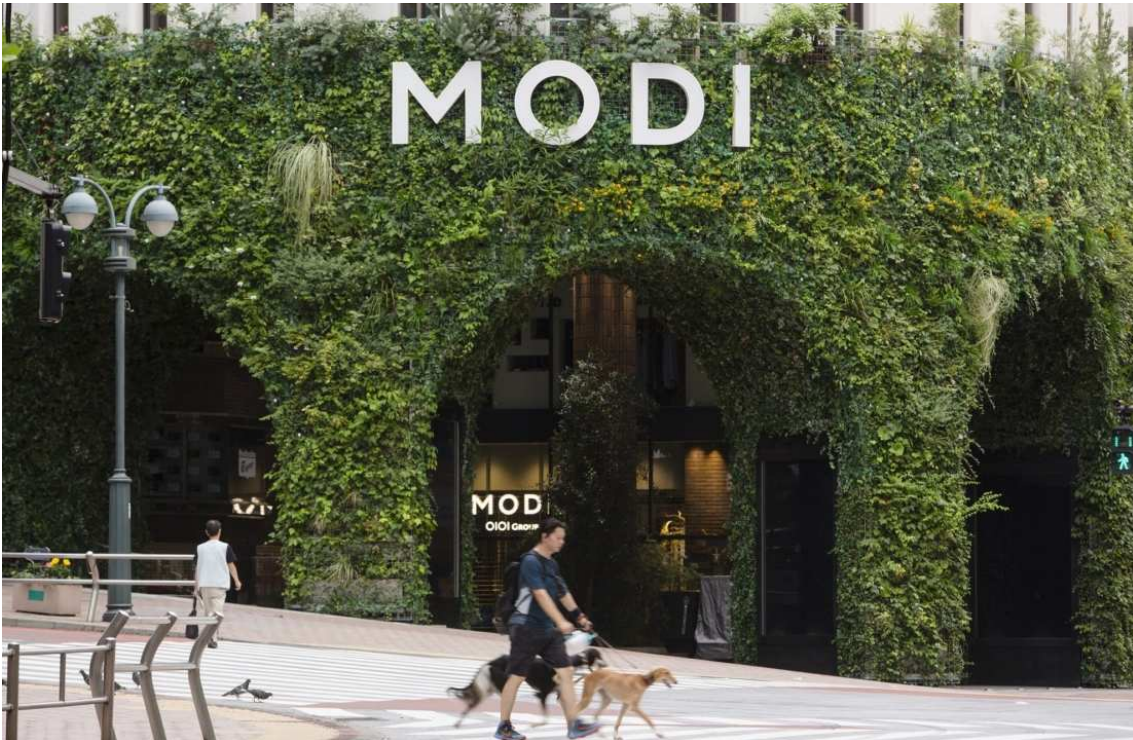
プランターユニットによる壁面緑化と広告を融合させ、緑豊かな玄関アプローチへと改修
