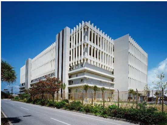
縦ルーバーを用いて壁面に凹凸を作ることで、圧迫感を軽減
