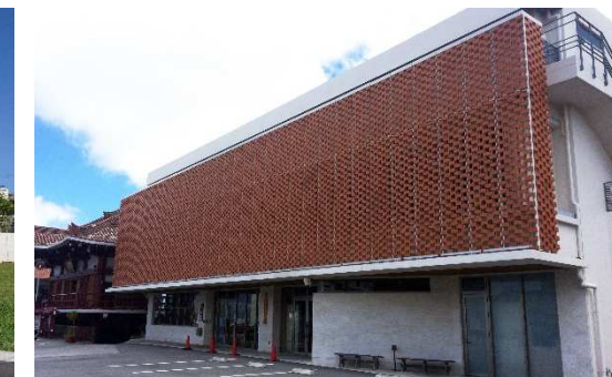
赤瓦と同系色のスクリーンブロックにより、周囲との調和に配慮
