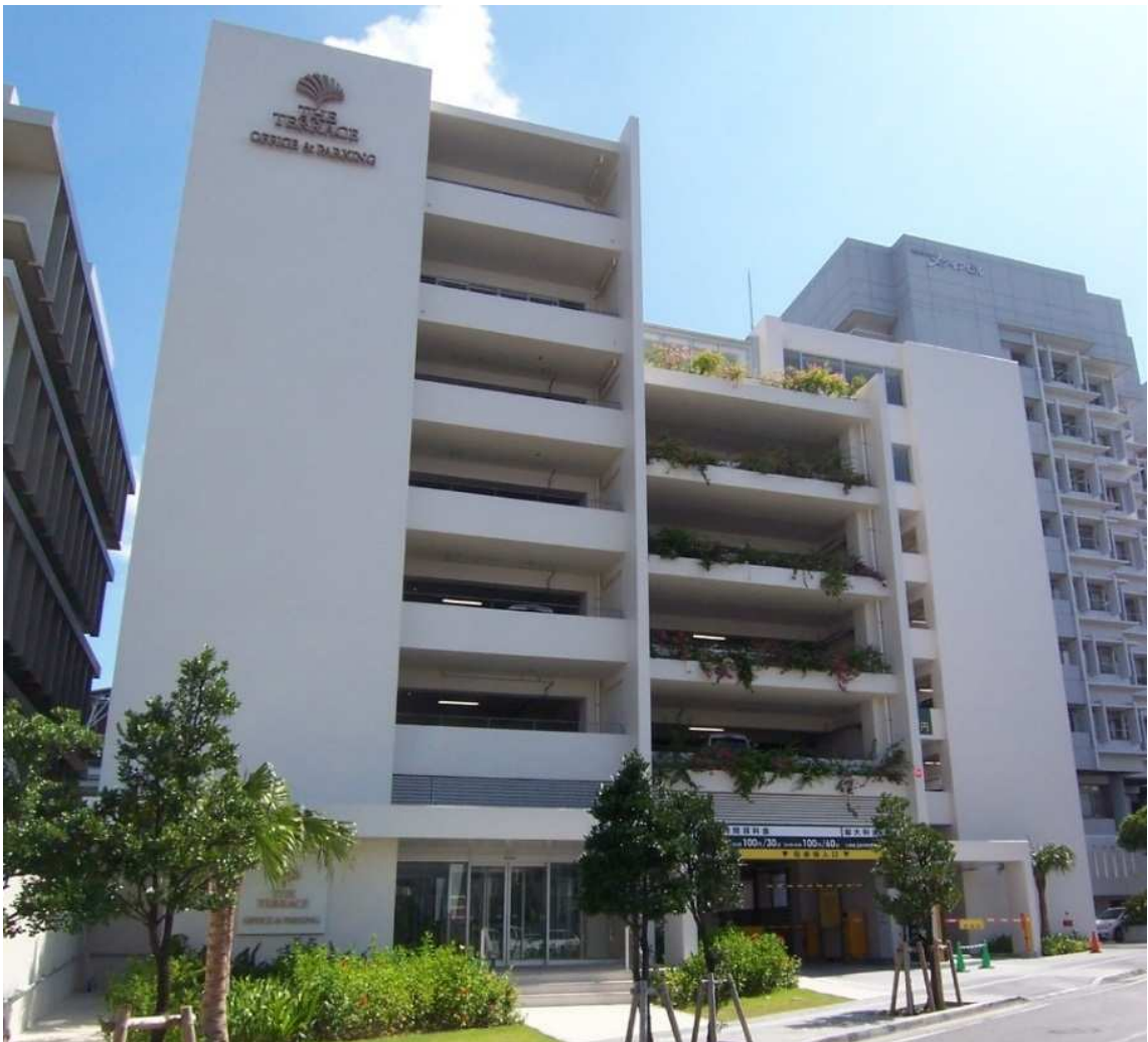
壁面側にプランタースペースを設けることで、駐車場壁面に表情の変化を与える
