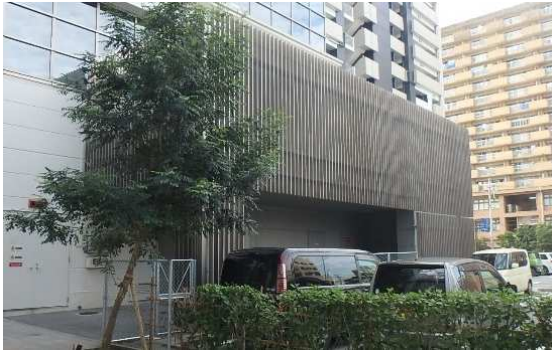
ルーバーで室外機を隠した事例
