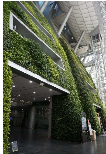
プランターユニットによる壁面緑化を行うことで、緑豊かな空間を創出
