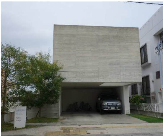
打ち放しコンクリートの素地色を生かし、杉板型枠を用いることで、外観に豊かな表情を演出
