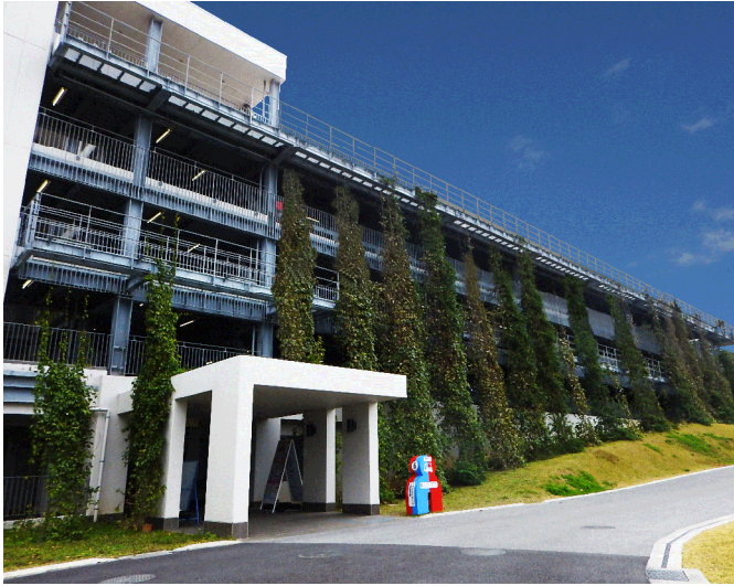
ワイヤーを用い地面から緑化することで、外観だけでなく植物の生育にも配慮
