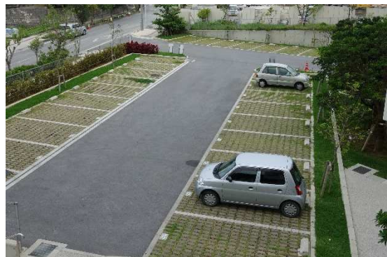
芝ブロックを用いて駐車場面を緑化
