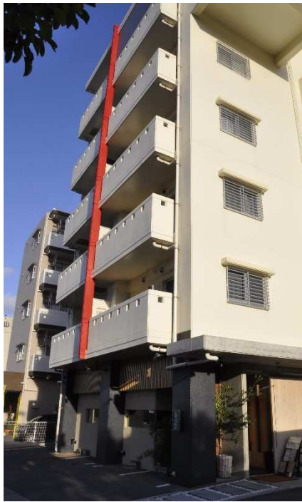
縦型の樋隠しにアクセントカラーを用いることで、建築物の表情を創出
