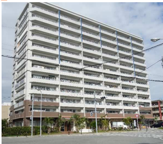
大規模な壁面の圧迫感を軽減するため、壁面の塗り分けを工夫
