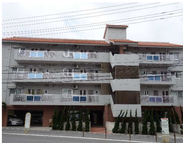
低層部には補助色による壁面の塗り分け、中高層部には赤瓦による屋根色がアクセントカラーとなり、色彩計画を通して建物全体を演出
