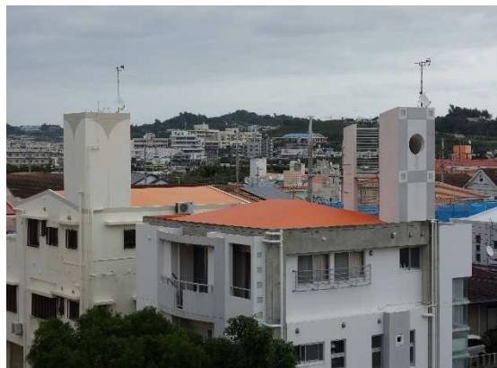
コンクリートで隠した事例
