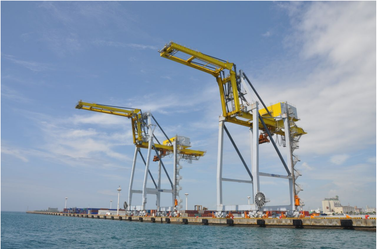
新港ふ頭・ガントリークレーンのある岸壁
