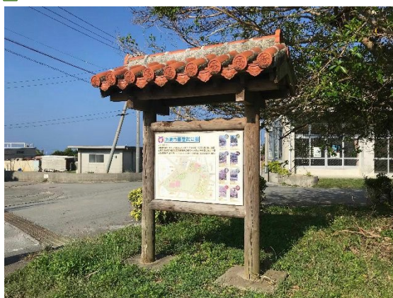
支柱等に木材を活用した事例 【糸満市：喜屋武公園】
