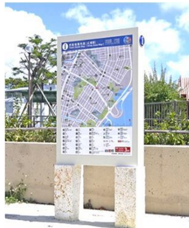
足元に空間を設け、車いす利用者でも近づくことができるように配慮したサインの事例【那覇市:久米至聖廟前】
