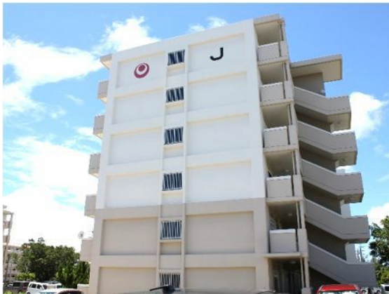
低層部に補助色を活用し、大規模な壁面の圧迫感を軽減するため、壁面の塗り分けを工夫した事例【豊見城市:豊見城団地県改良住宅】
