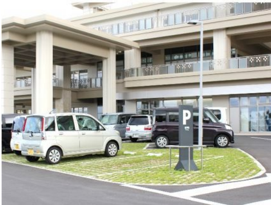
芝ブロックを用いて駐車場面を緑化した事例 【南城市：南城市役所】
