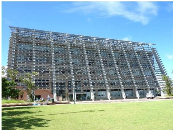
大型のルーバーを活用し、壁面の圧迫感を軽減するとともに、西日の侵入を防ぐ役割も果たしている【糸満市：糸満市役所】
