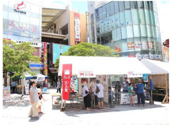
壁面部を後退させることで、ゆとりのある歩行者空間を形成するとともに、イベントなどが行える空間として整備した事例 【那覇市：那覇市ぶんかテンプス館前】
