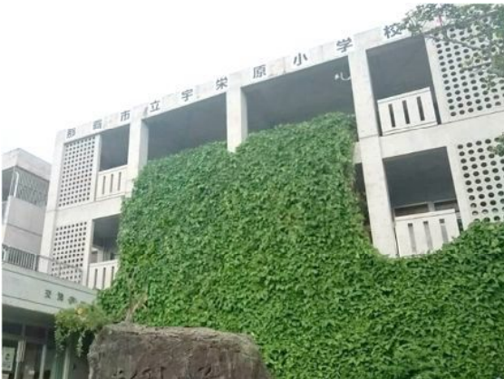
壁面の一部を緑化した事例 【那覇市：宇栄原小学校】
