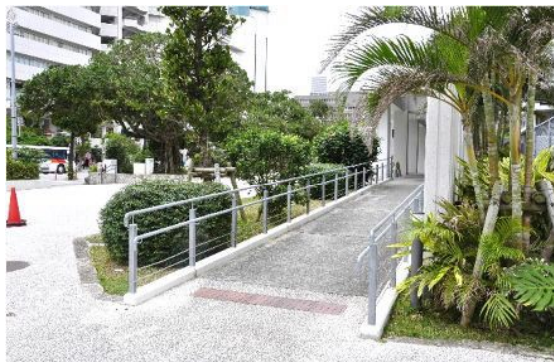
車いす利用者が通りやすい幅員を確保するとともに、その両脇を植栽することで、景観に配慮している事例【那覇市：那覇市役所】
