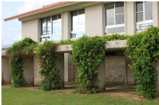
玄関までのアプローチ空間を屋上緑化と壁面緑化することで、潤いあるアプローチ空間を創出した事例【豊見城市：漫湖水鳥・湿地センター】
