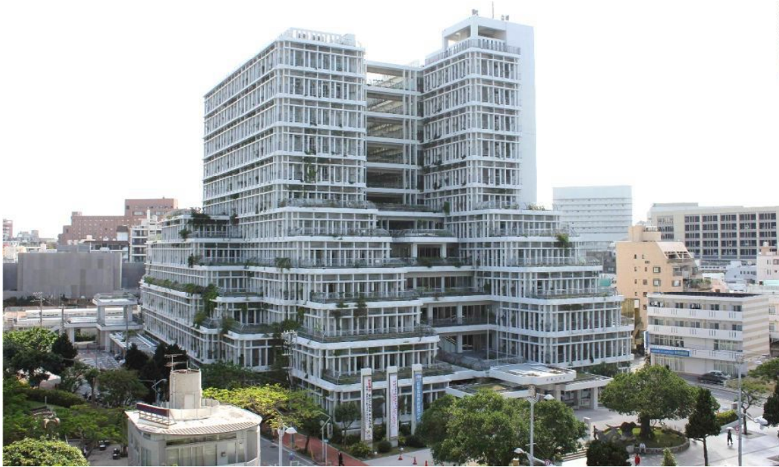
自然光や自然風を取り込みやすいつくりとし、圧迫感軽減に配慮されたデザインとなっている。また壁面緑化により『亜熱帯庭園都市』なはの景観』をイメージした建築物となっている【那覇市：那覇市役所】
