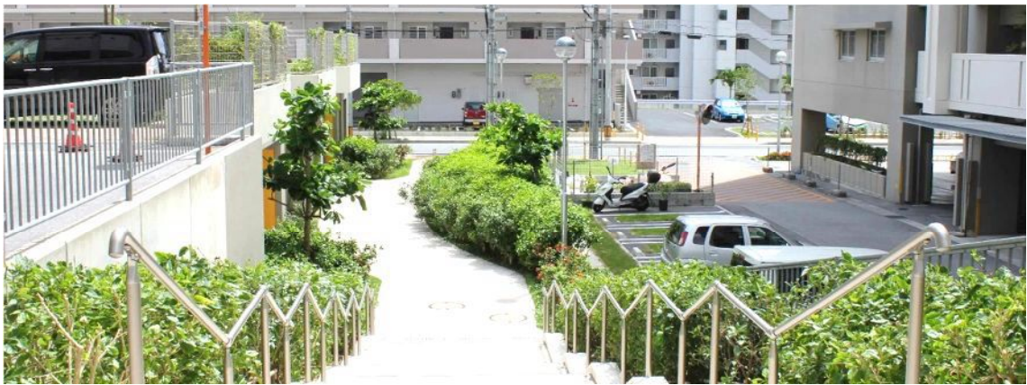
玄関までのアプローチ空間を緑化することで、潤いあるアプローチ空間を創出した事例【那覇市：石嶺市営住宅】
