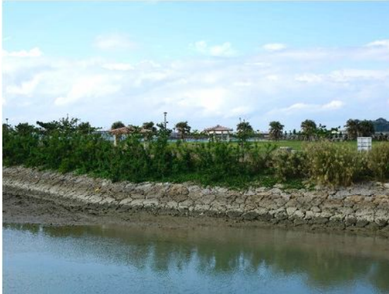
緩やかな勾配の護岸とし、その背後に緑地とオープンスペースを設けた事例【豊見城市：豊崎海浜公園】
