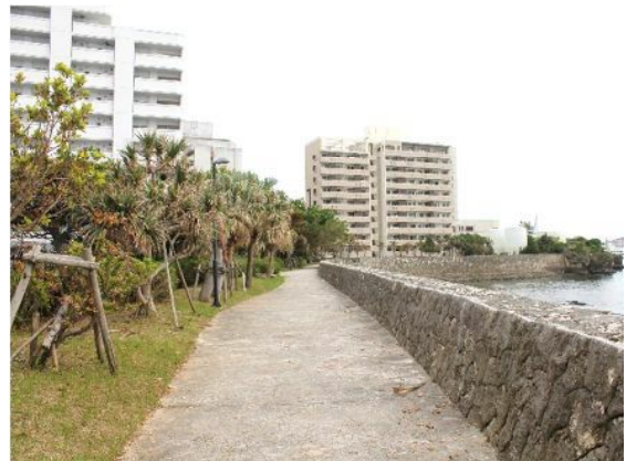
海岸沿いに遊歩道を設け、利用する方が海を眺めながら楽しめる歩行空間を形成した事例【那覇市：三重城ふるさと海岸】
