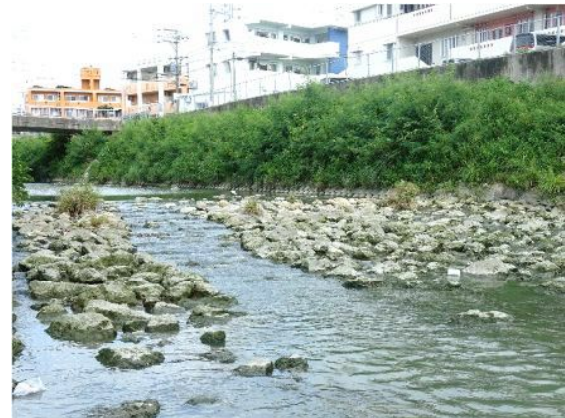
落差工を数段に分けて設け、その周りを自然石で周辺の景観に配慮した魚道の事例【南風原町：国場川】
