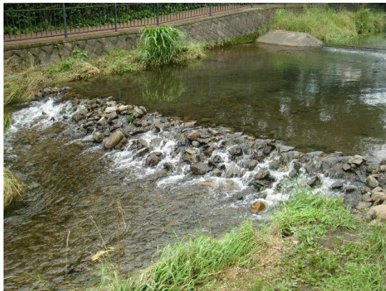
緩やかな落差工を設け、周辺の景観に配慮し自然石を活用した魚道の事例【東京都：落合川】
