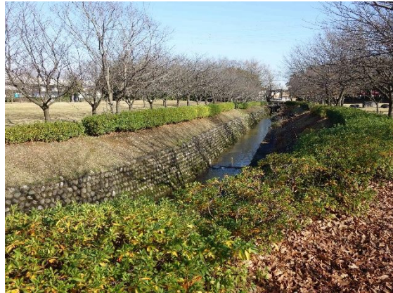
植栽による柵を設けることで周辺の景観にも配慮している事例 【富山県：稲荷公園】
