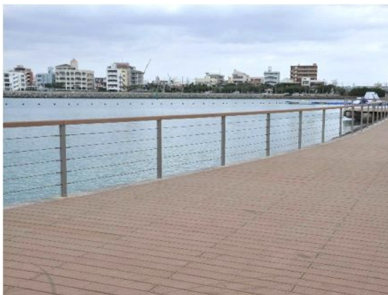
ビーム状の防護柵とし、透過性に配慮した事例 【北谷町：フィッシャリーナ】
