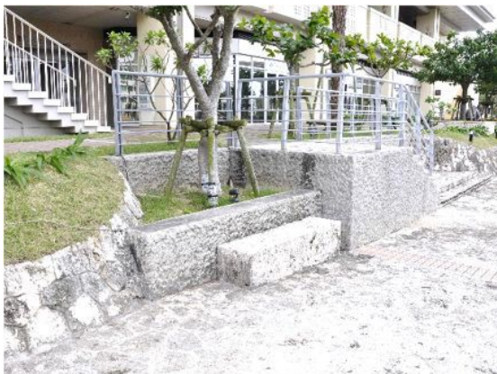
周辺の素材と調和させ、擁壁部と一体的に整備したベンチ 【那覇市：カーナ旭橋】
