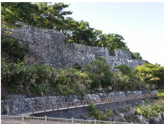
周辺の歴史性に配慮し、城壁をモチーフとした法面 【那覇市：金城ダム】
