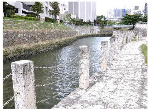
支柱を周辺の素材と調和させ、防護柵に鎖を活用することで、透過性に配慮した事例【那覇市：さいおんスクエア・安里川】
