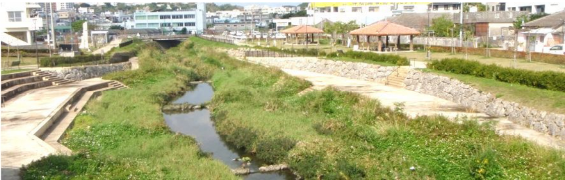
陸部は自然素材の護岸とし、河川部には緑化の護岸を形成することで、良好な河川景観を形成している事例【沖縄市：比謝川】
