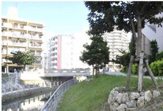
護岸部を緑化し高木を植栽することで良好な河川景観に配慮した事例【那覇市：さいおんスクエア・安里川】
