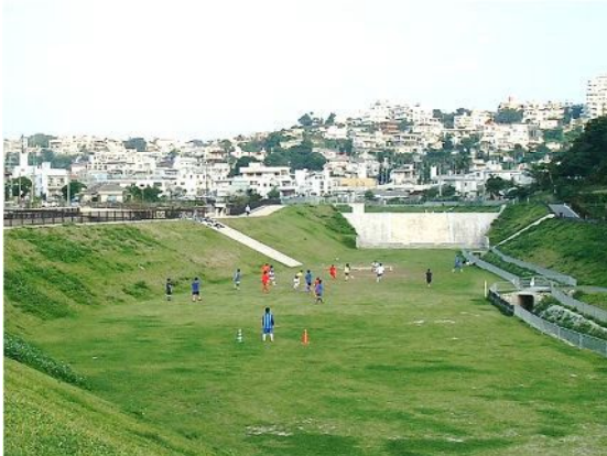
緑のオープンスペースを設け、多目的に有効利用を図っている事例 【那覇市：真嘉比遊水地】
