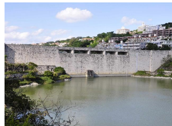
周辺の景観と調和させた琉球石灰岩の構造物 【那覇市：金城ダム】 <第12回 那覇市都市景観賞>
