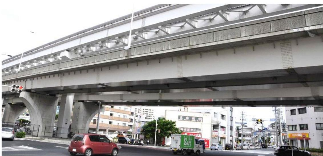
立体交差の高架部分のデザインをシンプルにして、光が差し込むように工夫した事例
