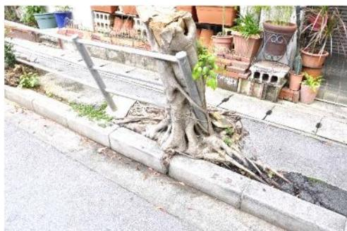
根上がりによる縁石の破損
