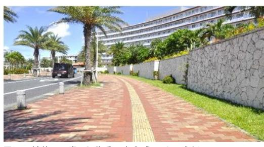
周辺の舗装に配慮した黄系の点字ブロックの事例
