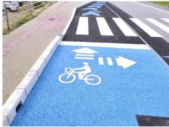
誘導サインの設置は行わず、路面に表示した誘導サイン
