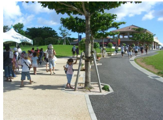
縁石部をフラットにし、段差を解消した事例 【本部町：海洋博公園】
