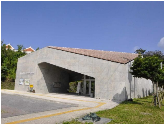
公園のエントランスの役割も果たしている管理棟 【浦添市：浦添大公園】
