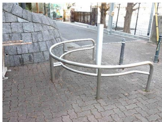
オートバイの進入を防ぐように配慮した進入路 【東京都：清水坂公園】
