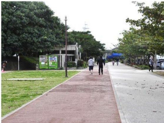
利用者の負担軽減のため、ゴムチップ舗装を行った事例 【那覇市：新都心公園】
