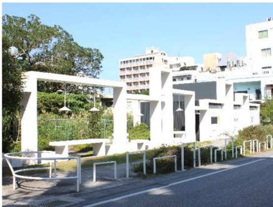
休憩施設と一体化したトイレ。公園のエントランスの役割も果たしている 【那覇市：緑ヶ丘公園】
