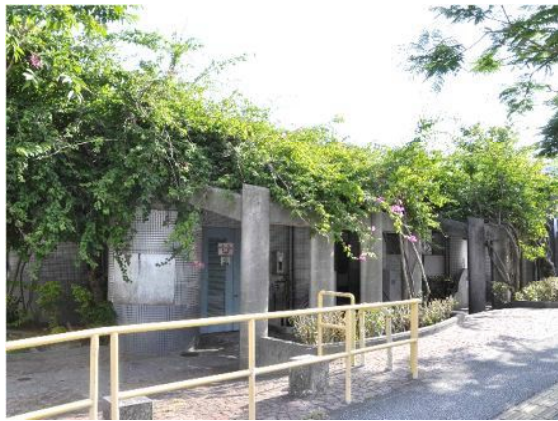
屋上部を緑化することで公園の持つ自然景観に配慮した事例 【那覇市：松山公園】
