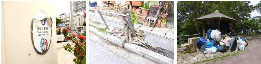
公共サインの剥離
