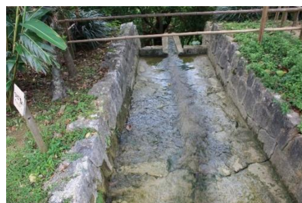
図5-2：亀裂が生じている水路（滝口）
