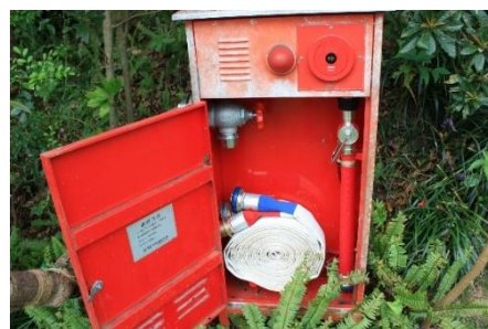
図 5-6：一人での稼働が困難な屋外消火栓
