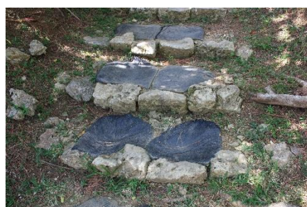
図5-3：土囊で補修している石階段
