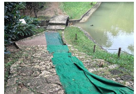
図 5-11：滑りやすく歩きにくい観賞動線（現状は階段にシートを敷いて対応）
