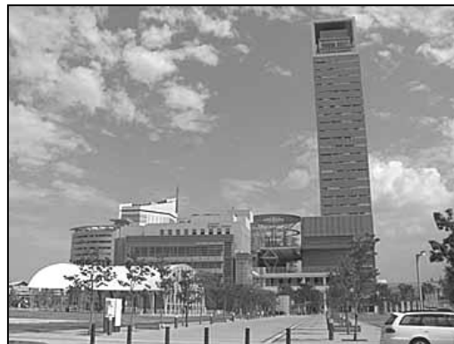
シンボルタワー
