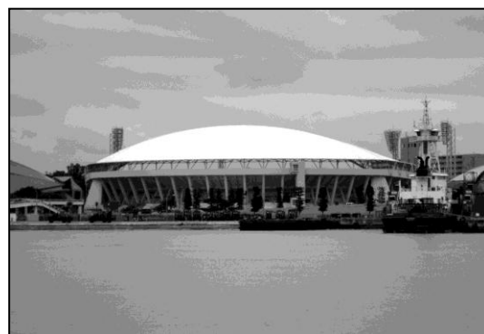
整備中の(仮称)那覇市営奥武山野球場
