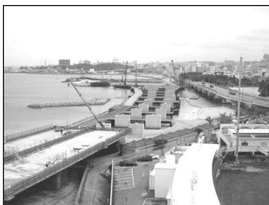
整備中の臨港道路空港線
