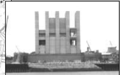
整備中の臨港道路空港線の換気塔(空港側)
