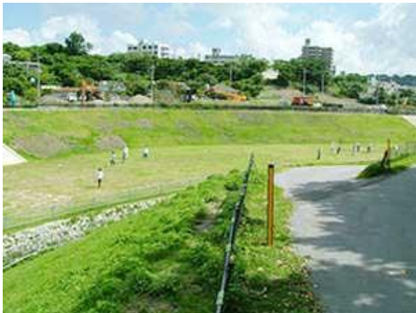
安里川流域の治水対策として整備された真嘉比遊水池。普段は市民のレクリエーションの場として活用されている。まちなかの緑が防災・減災として活用されているグリーンインフラの事例のひとつ。
