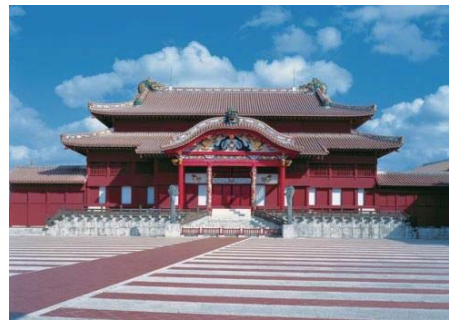
焼失前の首里城正殿
