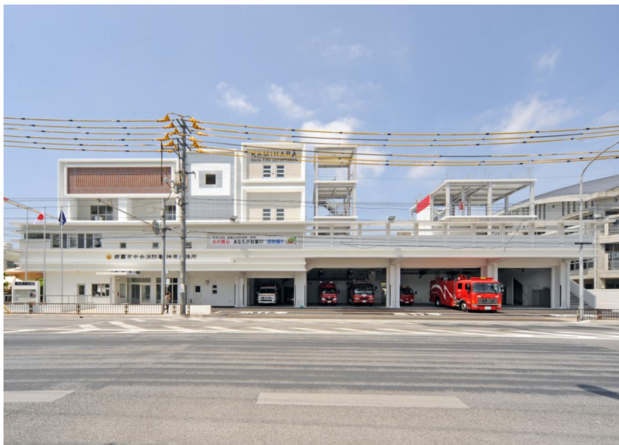
平成 27 年度に完成した中央消防署神原出張所
