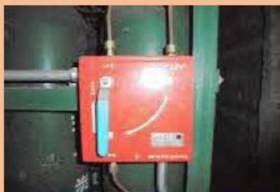
閉止弁 (操作管)
