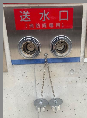
送水口の蓋は取り外し可能 通常はチェーンで接続されている
