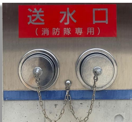
送水口の蓋は取り外し可能 通常はチェーンで接続されている
