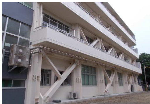
耐震改修(城岳小学校)
