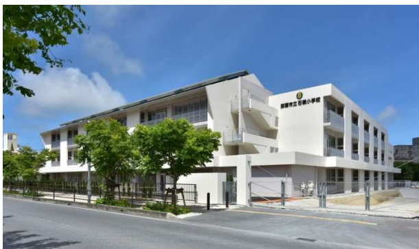
校舎改築(石嶺小学校)
