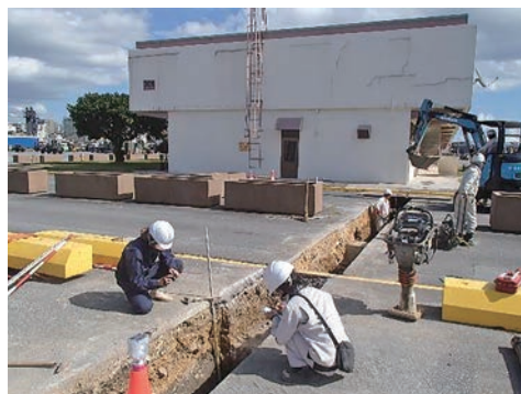
立会調査の様子
