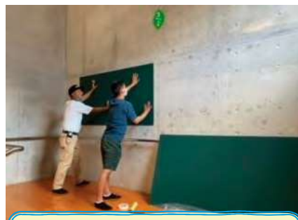
掲示板の取付け作業
