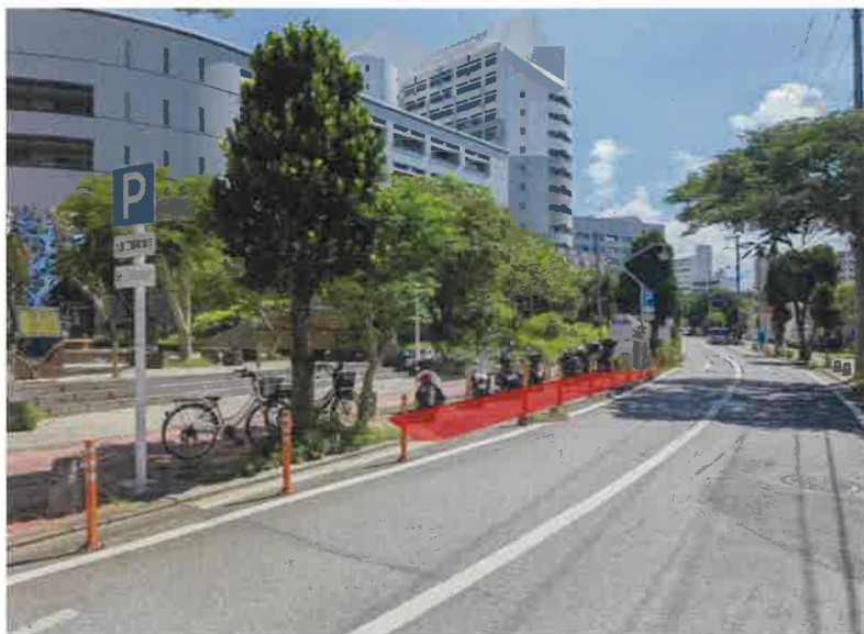
既設二輪駐車場①
