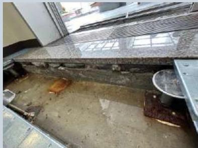
3階排水不良による床下漏水
