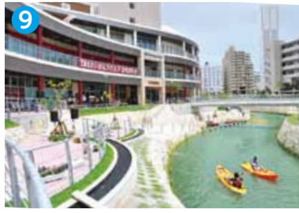
さいおんスクエア (安里川親水公園) 平成23年オープン。地区内を大きく蛇行して流下していた安里川の流れを緩やかにし、断面積を広げた。水辺に近づく、ウナギ、カニ類、ミナミトビハゼ等の豊かな生態系が観察できる。琉球王国時代の政治家・土木技術者である蔡温の名を冠した蔡温橋のたもとにある。
