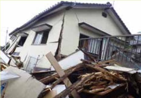
熊本市内の倒壊家屋
