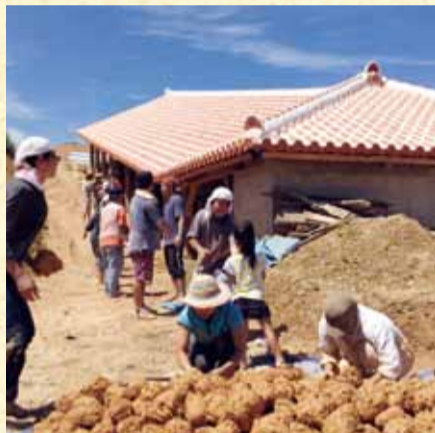
窯の天井にのせる土を運ぶ様子
