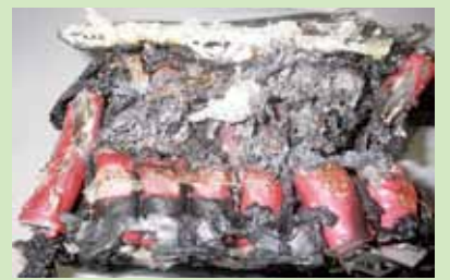
火災発生現場付近にあったバッテリーなどの拡大写真
