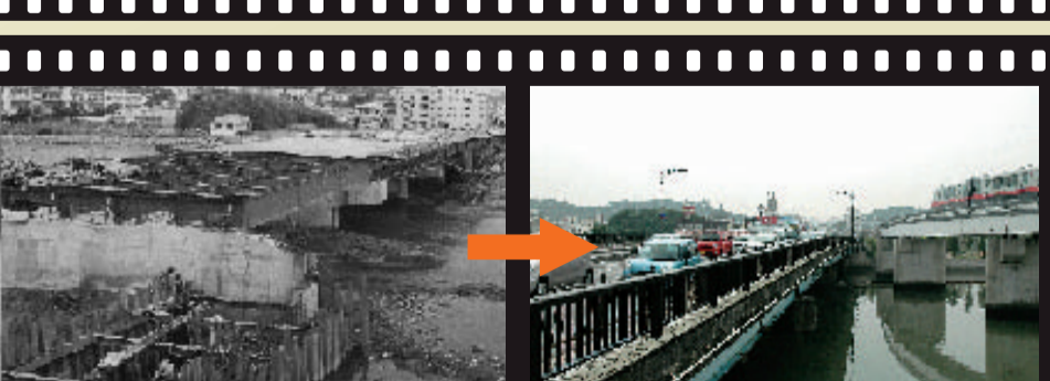
工事中の那覇大橋(奥はガーナムイ)
