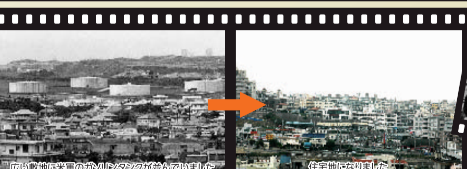
広い敷地に米軍のガソリンタンクが並んでいました
