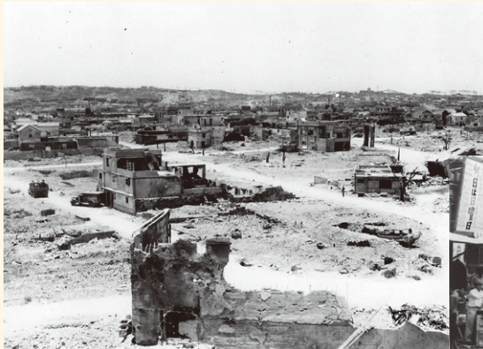
破壊された西町・通堂町付近
