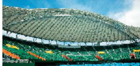
来年3月完成予定の奥武山野球場。要請によれば、この大屋根の上から更に屋根を被せることになる。
