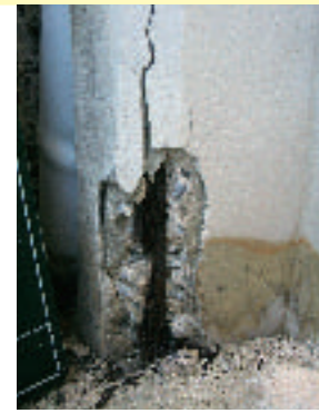
庁舎柱のひび割れ
