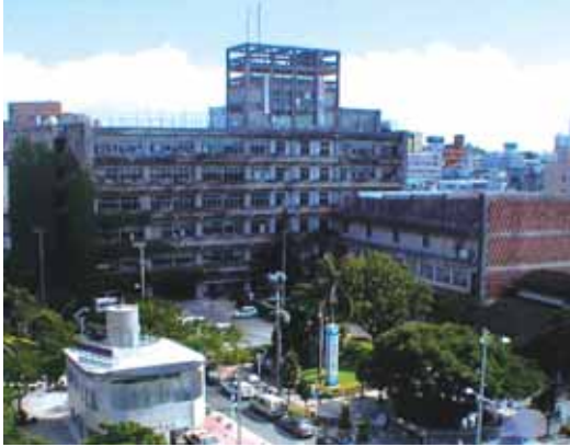
築41年になり老朽化が進む市役所本庁舎
