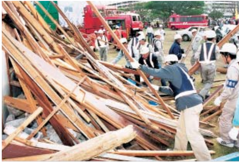
倒壊建物の瓦礫を撤去する市職員
