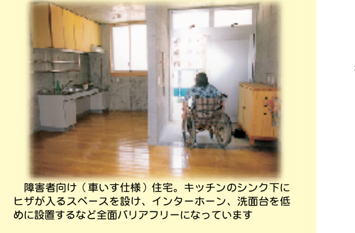
障害者向け（車いす仕様）住宅。キッチンのシンク下にヒザが入るスペースを設け、インターホーン、洗面台を低めに設置するなど全面バリアフリーになっています
