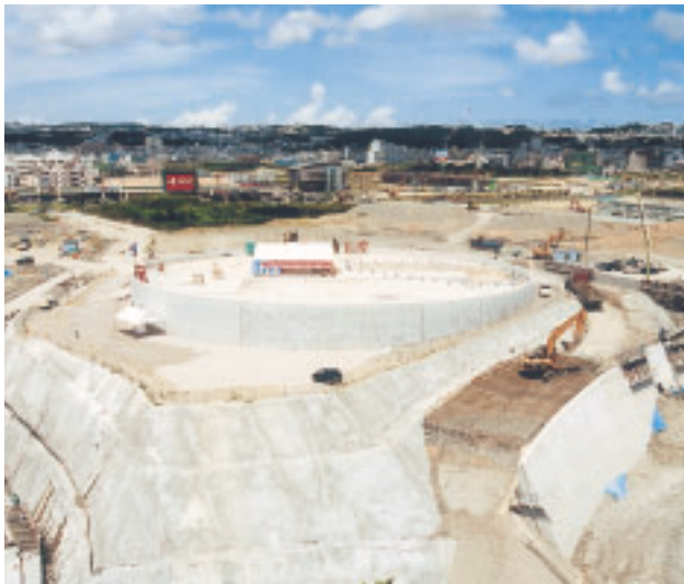
完成すると那覇市で最大の配水池となる泊配水池
