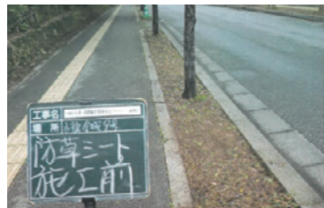
▲防草シート設置前
