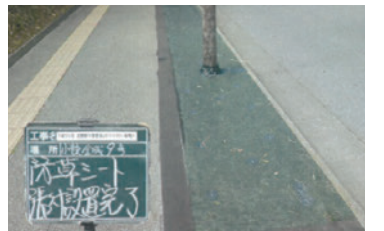
▲防草シート設置後
