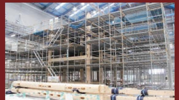
素屋根内部。正殿の柱はヒノキを使用しています
