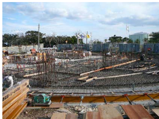
【納骨堂鉄筋組立状況】
