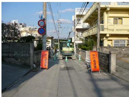
【作業箇所の歩行者通路確保状況】
