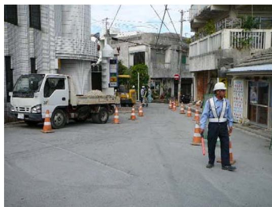
【作業箇所での交通誘導員配置】
