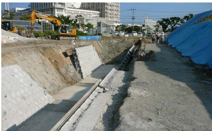
〔写真-5.間知ブロック積施工状況・下流部より上流部を望む〕
