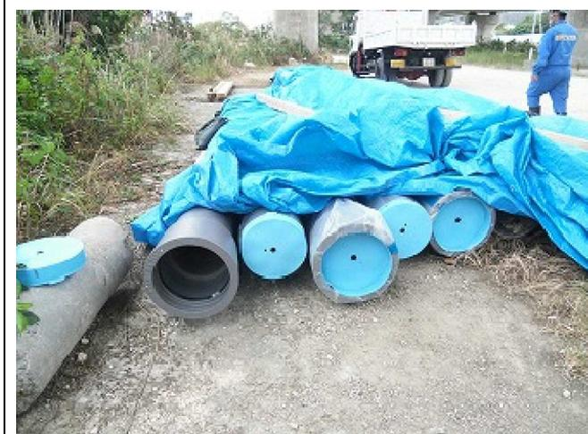
No. 3 資材保管場所において、工事に使用する配管材が適切に保管されている。
