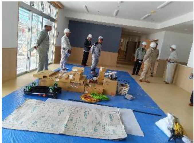
写真6 現場施工状況（室内）
