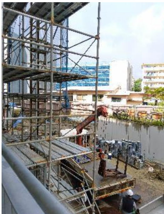
写真3 現場施工状況
