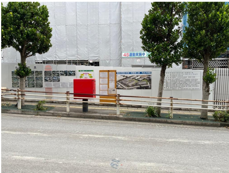
写真7 工事看板設置状況
