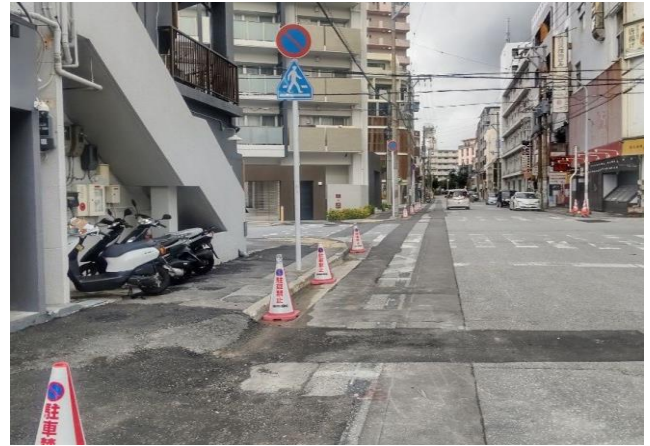
写真 9 現場施工状況
