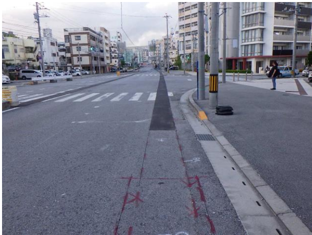
写真 12 現場施工状況
