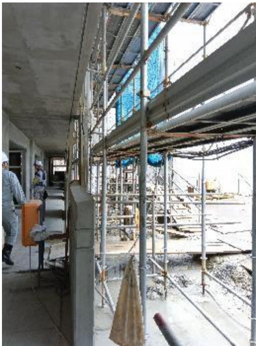
写真5 現場施工状況
