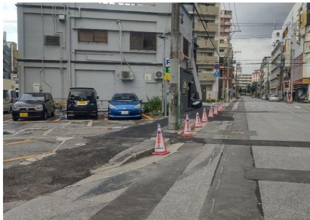
写真 10 現場施工状況
