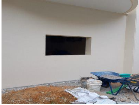
写真10 耐震壁増設完了
