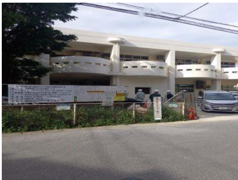
写真9 南面及び工事看板
