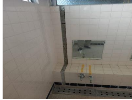
写真11 浴室腰壁耐震スリット設置
