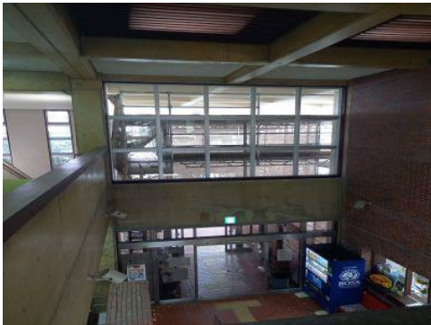
写真12 ホール上部建具改修
